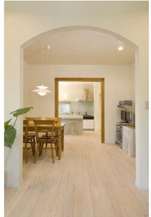
無垢パインのフローリングは植物由来の塗料リボス仕上げ。1回塗りで自然な木目を生かした。
