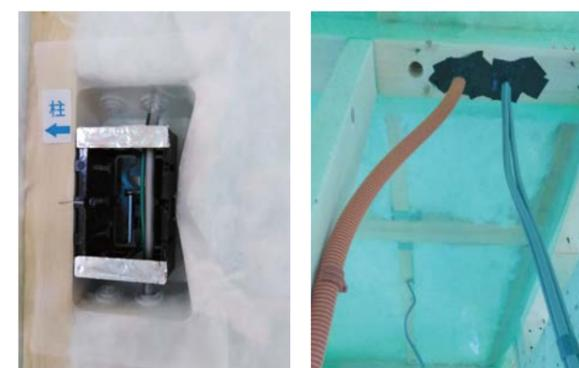
コンセントボックスの周りも、隙間なくグラスウールを施工しています。パイプの隙間はテープで塞ぎ、気密性を高めています。
