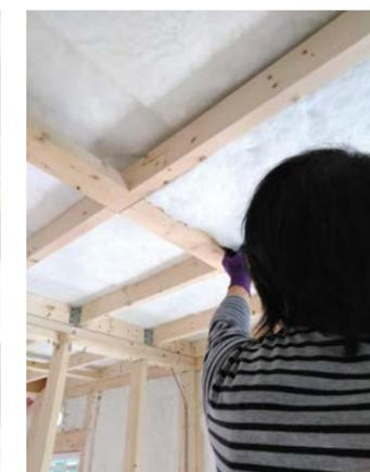
グラスウールは詰め込まず隙間なくぴったりと施工し、性能を発揮させます。
