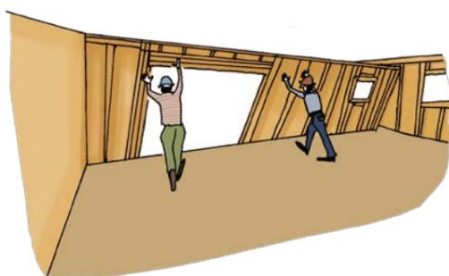
規則に基づいて造れば、所定の性能を確保できるという考え方です。ルールブックには、使用する釘の太さや打ち方、枠組の造り方など、様々な規則が詳細に書かれています。第二に、「線（柱）ではなく面（壁）を基本単位」としたことです。これは、木造住宅の歴史上、とても重要で画期的なアイデアでした。細い木材でも壁として一体化することで、太い柱よりも強い剛性を持つようになるのです。これらの考え方をさらに推し進めた工法が、私たちグッディーホームズもこだわっている「木造枠組壁工法（ツーバイフォー工法）」です。
