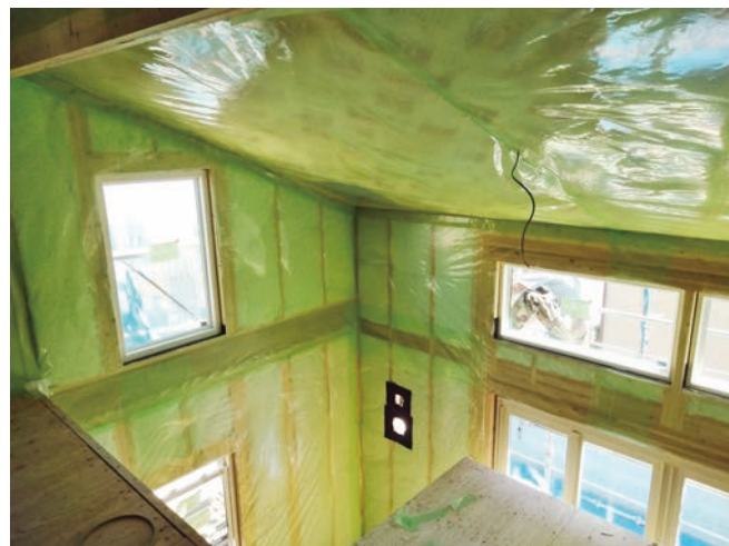
グラスウールは詰め込まず隙間なくぴったりと施工し性能を発揮させます。
