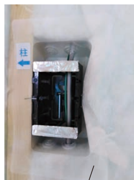
コンセントボックスの周りも隙間なくグラスウールを施工。
