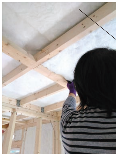
グラスウールは詰め込まず隙間なくぴったりと施工し性能を発揮させます。
