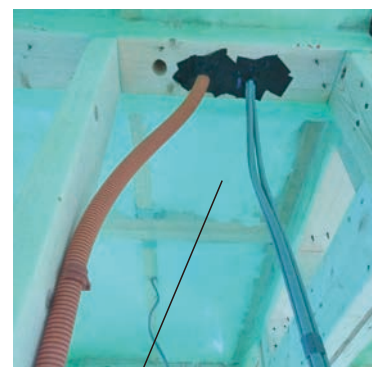
パイプの隙間はテープで塞いで気密を高めています。
